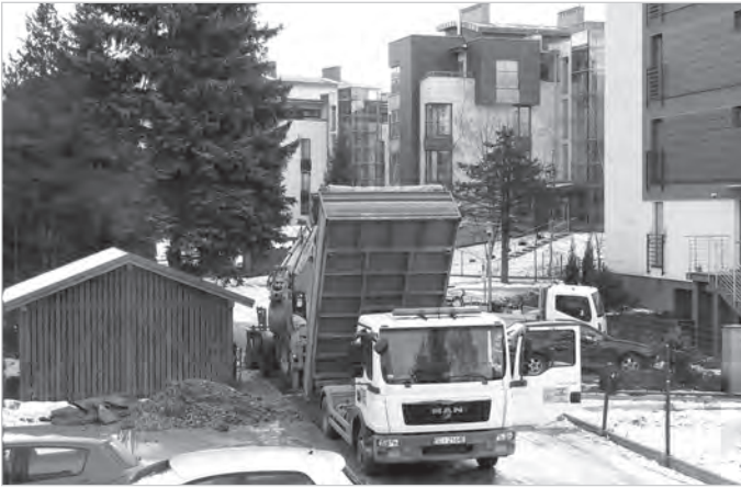
Zasypywanie dołu, w którym naprawiano rury. Fot. M. Niemiec
