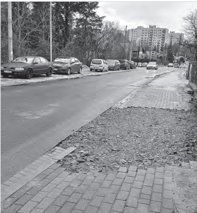
Prace prowadzone były pod tym fragmentem drogi i chodnika. Fot. M. Niemiec
