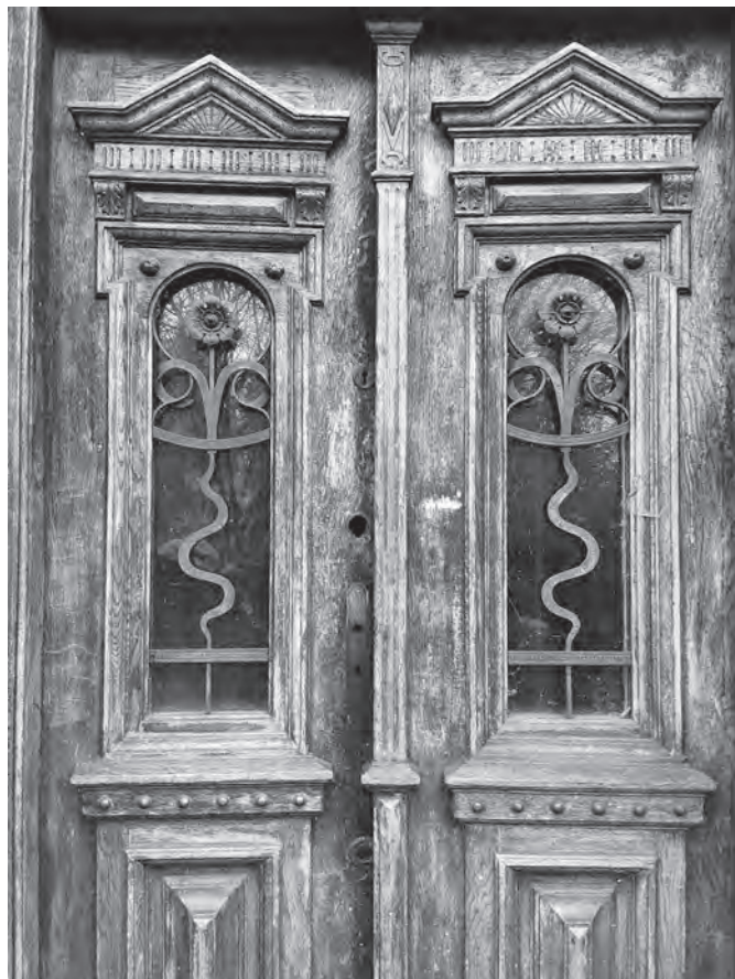
Oryginalnie zachowane drzwi wejściowe.
