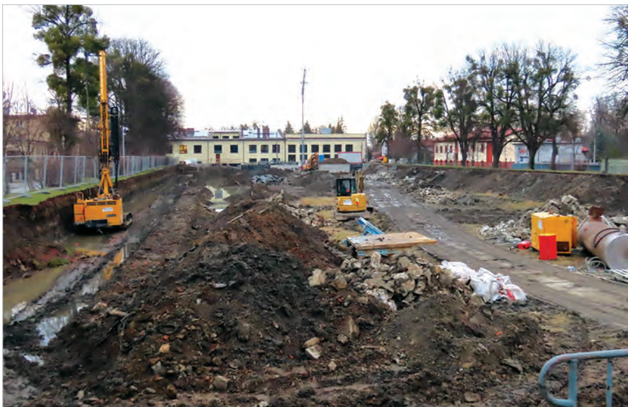
Pogoda sprzyja, więc trwają prace na stawie kajakowym.
