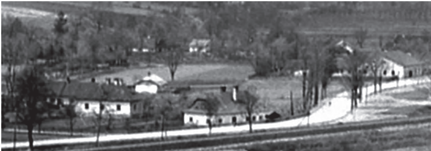
Brzegi w latach międzywojennych. Z lewej strony dom mieszkalny dla pracowników leśnictwa, w centrum obiekt administracji leśniczówki. Z prawej w tle gospoda Heinricha (dziś Zbiory Marii Skalickiej).
