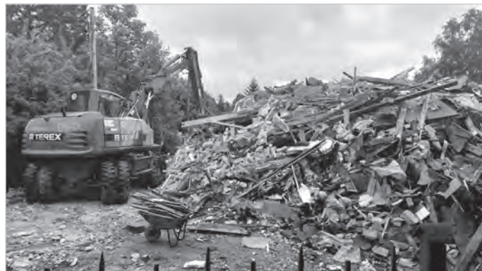
Zdjęcie z rozbiórki willi „Mon repos”.
