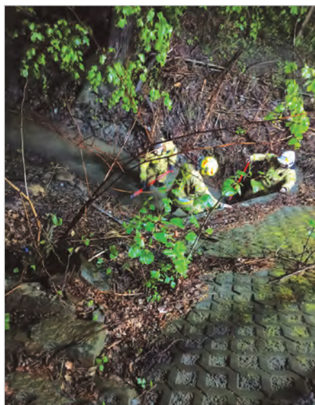
Hermanice, oczyszczanie śluz nr 8.
